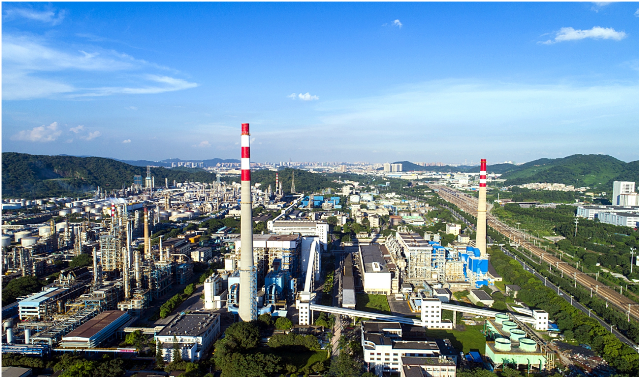
广州石化CFB锅炉
