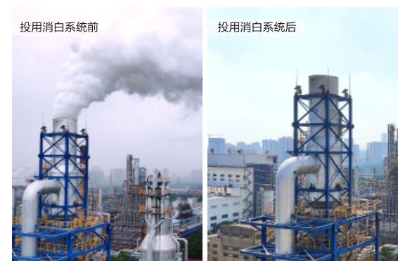
FCC烟气深度除尘除雾消白项目改造
