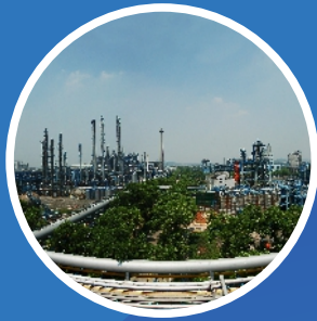
① 化工苯乙烯装置 脱氢尾气 氢纯度94%
