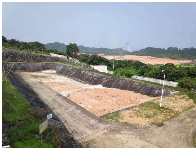
乙烯工程固废废弃物掩埋场现场照片
