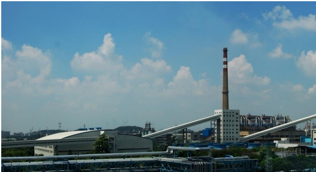
CFB 锅炉耦合燃料装置现场照片
