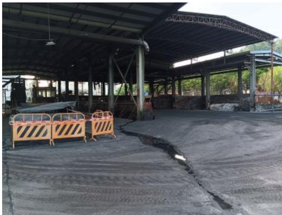
现有三泥搅拌设施现场照片
