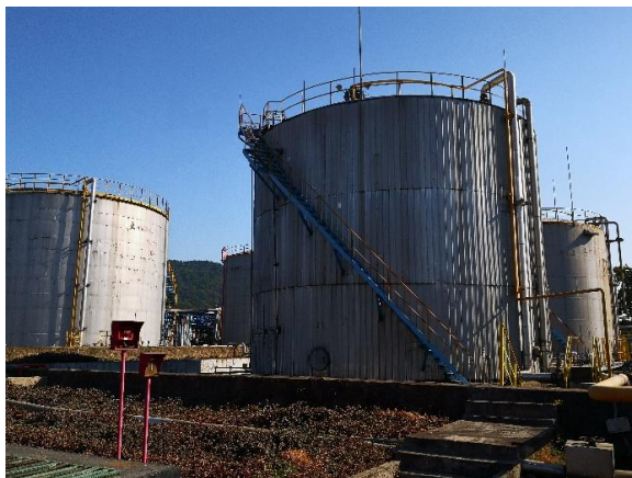
污油储罐现场照片
