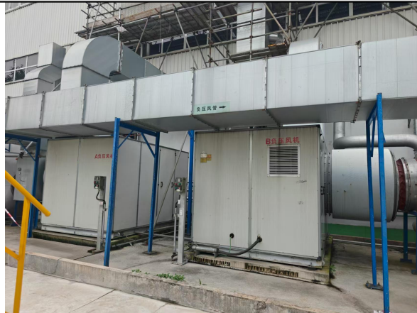
负压风机设置隔音罩
