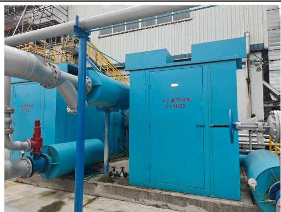
废气风机设置消声器
