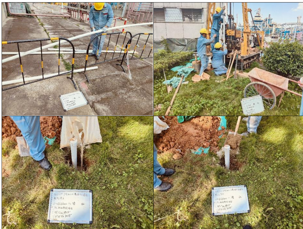
图 7-3 监测水井现场建井照片
