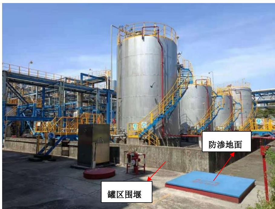
图 4-3 罐区围堰
