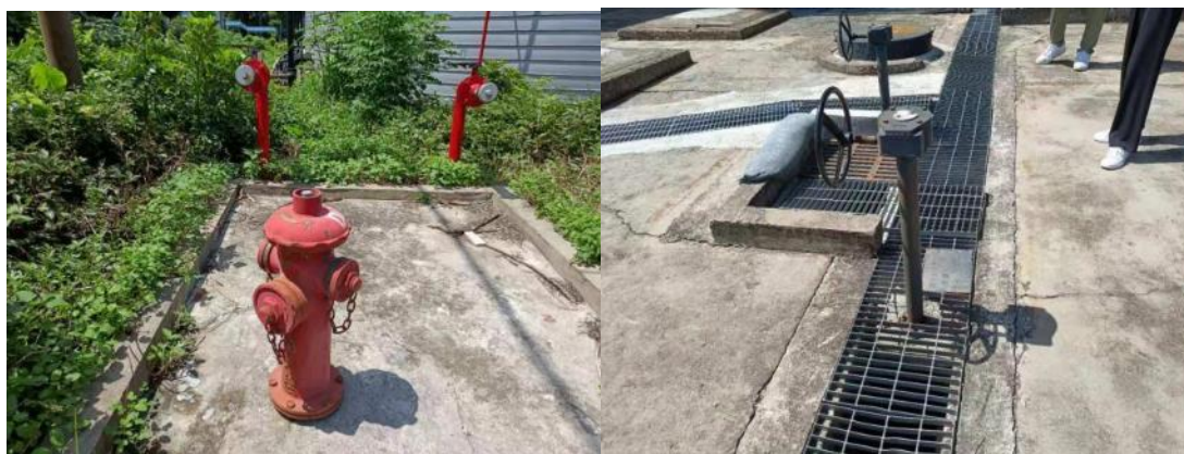
图 4-4 厂区内雨水渠截止阀（装置区、储罐区）
