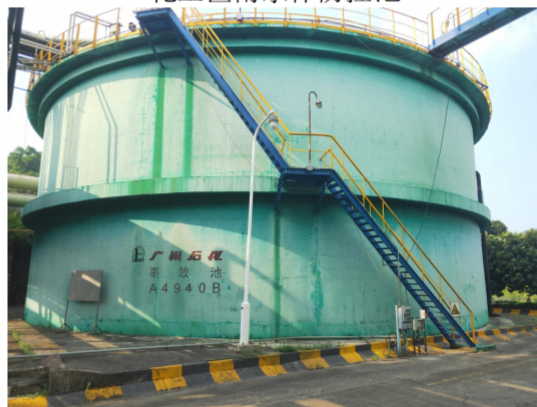
化工区事故调节池
