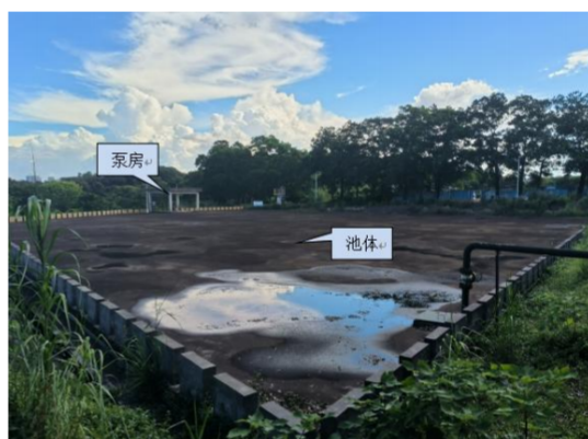
化工区南水体防控池
