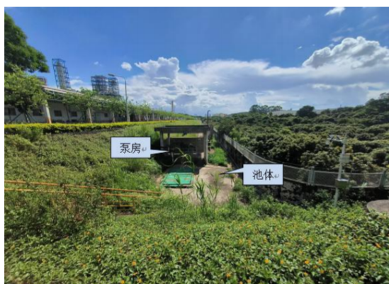
化工区北水体防控池
